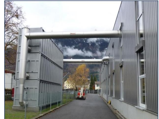
Bio-Filter hinter einer Abluftreinigungsanlage
